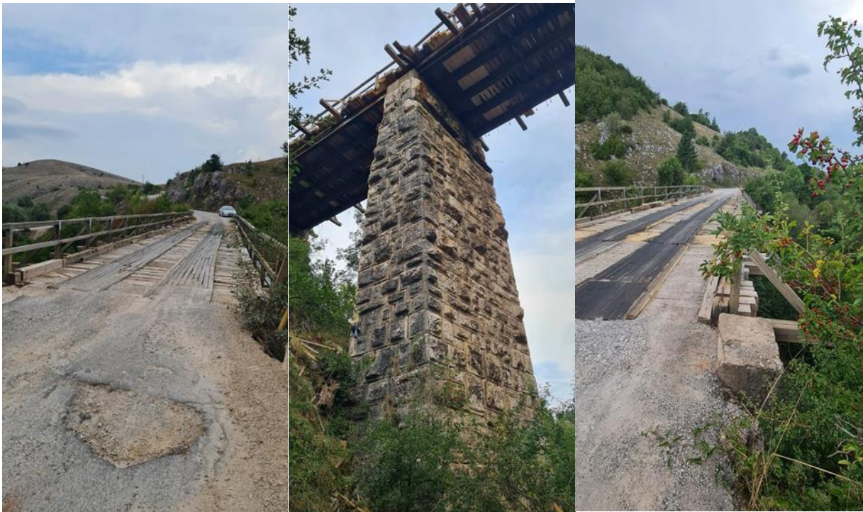
Slika 4. Trenutno stanje mosta na rijeci Tatinac
